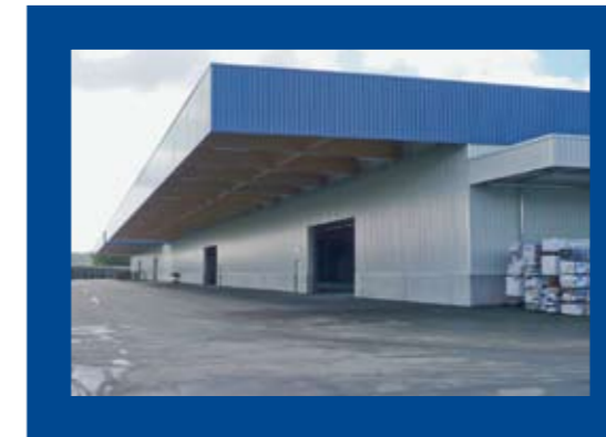
Viel Platz für große Lieferstärke: Die neue Lagerhalle ist 171 m lang.
