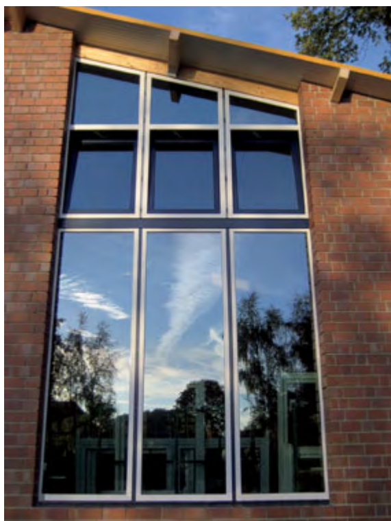
Bild 3: Zum VEKA Kopplungssystem gehören waagerechte wie auch senkrechte Profile, die sich für die Konstruktion von großflächigen Fensterbändern eignen.
